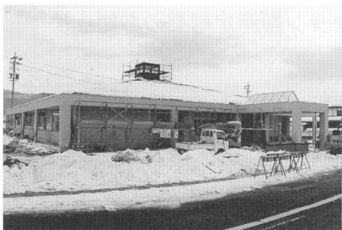
建設中のふれあいプラザ。鉄骨造平屋建、延べ床面積823㎡
