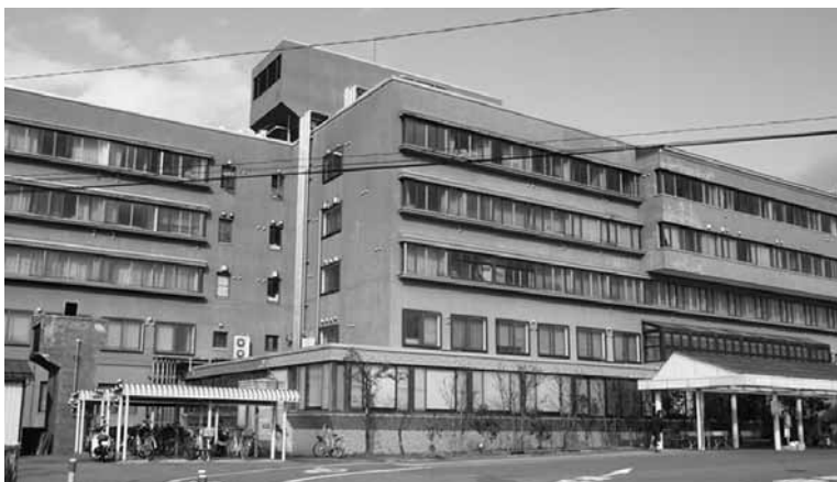
▲耐震改修工事を行う西病棟
