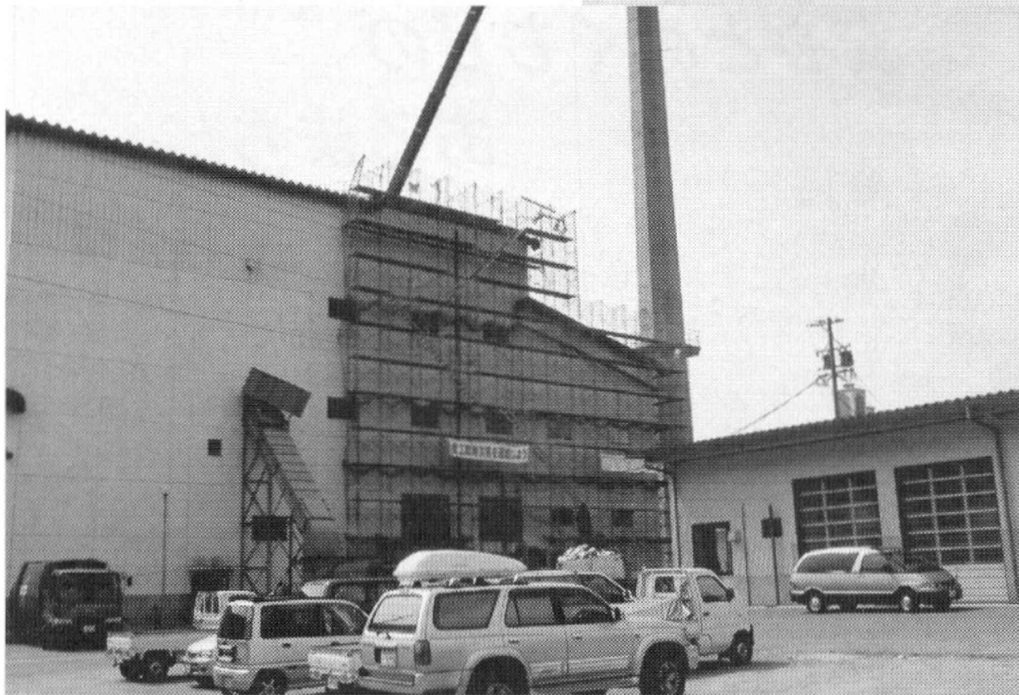
改修工事が進む環境プラント
