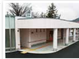
平成18年 信濃大町駅前公衆 トイレ完成
