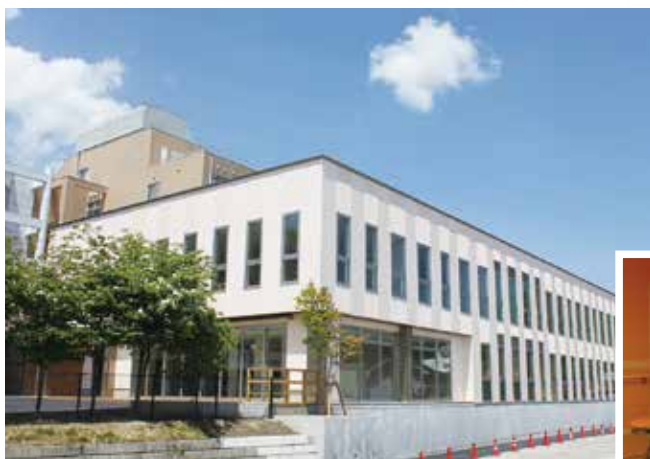
南棟（愛称・さくら）は、1 階に内視鏡室、レストラン、2 階に健診センターが入り、災害時には 1 階の講堂で傷病者を受け入れます
